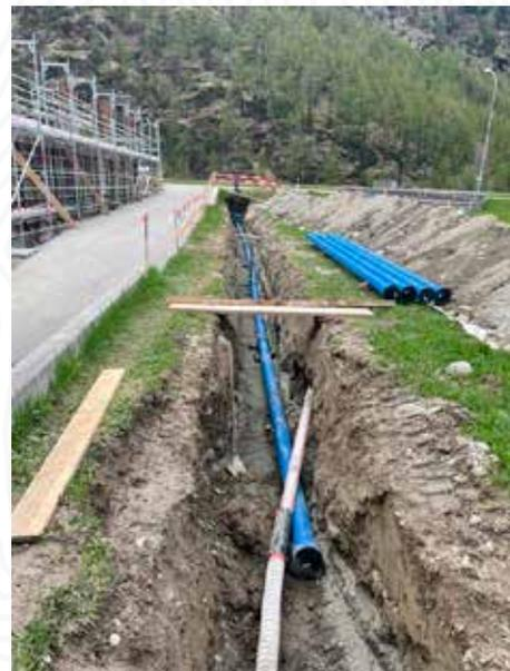
Im August 2021 wurde ein Stresstest des Leitungsnetzes in Täsch durchgeführt, welcher mögliche Defizite der Wasserversorgung aufzeigen sollte. Es wurde festgestellt, dass bei grossen Wasserbezügen der Systemdruck im Bereich «Kantonsstrasse» zusammenbricht.
