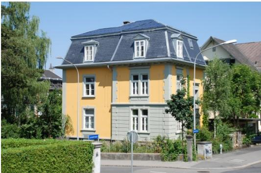
**Bild 7: Haus Hutterli/Röthlisberger, Bern: Schutzobjekt von kantonaler Bedeutung, 2.7 kW Photovoltaikanlage und Kollektoren unter den Naturschieferplatten. © Schweizer Solarpreis 2014**
