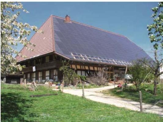
**Bild 1: Vollflächig integrierte Photovoltaikanlage, erfüllt alle Gestaltungsvorgaben von Art. 32a Abs. 1 RPV. © Schweizer Solarpreis 2011**
