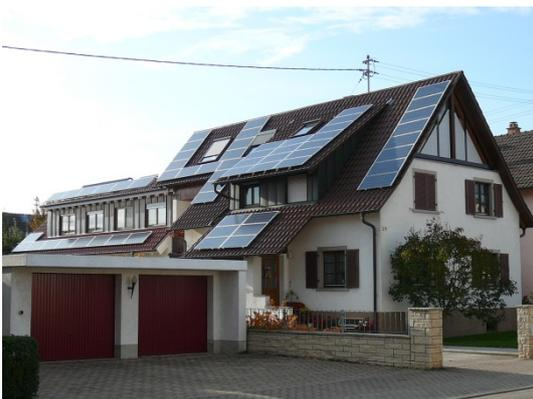
**Bild 2: Photovoltaikanlage, die keine „kompakte Fläche“ bildet. Bild aus Deutschland.**
