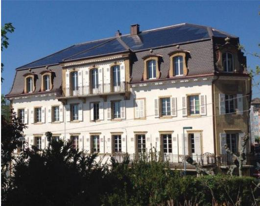
**Bild 9: Hôtel des Associations, Neuchâtel, im Quartier du Tertre, ISOS-Inventar mit Erhaltungsziel A. Dachintegrierte Photovoltaikanlage mit 28 kW. © Schweizer Solarpreis 2015**
