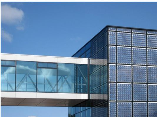
**Bild 6: Photovoltaik-Fassadenanlage. Ordentliche Baubewilligung erforderlich, sofern der Geltungsbereich des Meldeverfahrens vom Kanton nicht ausgedehnt wird. © Energiebüro**
