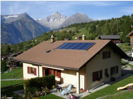
**Bild 4: Solarwärme-Aufdachanlage auf Steildach, überragt Dachfläche um weniger als 20 cm und erfüllt somit die Vorgaben von Art. 32a Abs. 1 RPV. © Vescal / Walter Meier**
