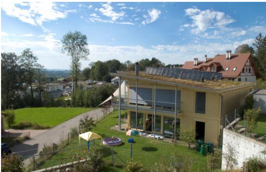
**Bild 5: Solarwärme-Aufdachanlage auf Flachdach, um mehr als 20 cm aufgeständert. Ordentliche Baubewilligung erforderlich, sofern der Geltungsbereich des Meldeverfahrens vom Kanton nicht ausgedehnt wird. © Swissolar**
