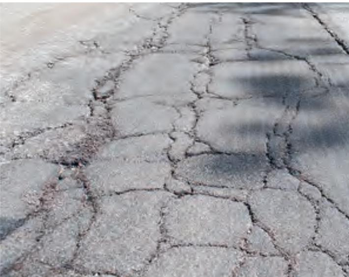
Der auf der talseitigen Fahrspur gerissene Asphalt, und das darunterliegende Koffermaterial, wird bis ca. in die Mitte des Strassenquerschnitts geschnitten, entfernt und abtransportiert. Mit dem Pneubagger wird das abgesackte Material ausgehoben und zwischendeponiert. Der Aushub ist zwingend so anzulegen, dass die talseitige Böschung bestehen bleibt.
